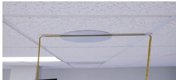
La instalación se hace de una manera sencilla, después de hacer el orificio para instalar la bocina en el falso techo se tiene que colocar el montaje por la parte interna ajustando al tamaño de la bocina, al momento de ajustar las dog ears harán que el soporte y la bocina queden ajustadas al plafón distribuyendo correctamente el peso.
